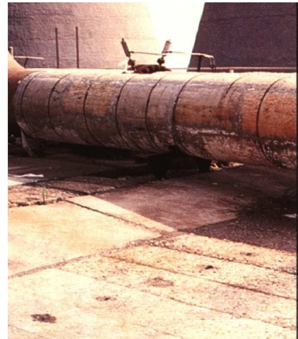
Rivestimento di amianto su tubazione (coppelle)
