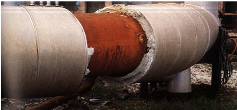
Rivestimento di amianto su tubazione (coppelle)
